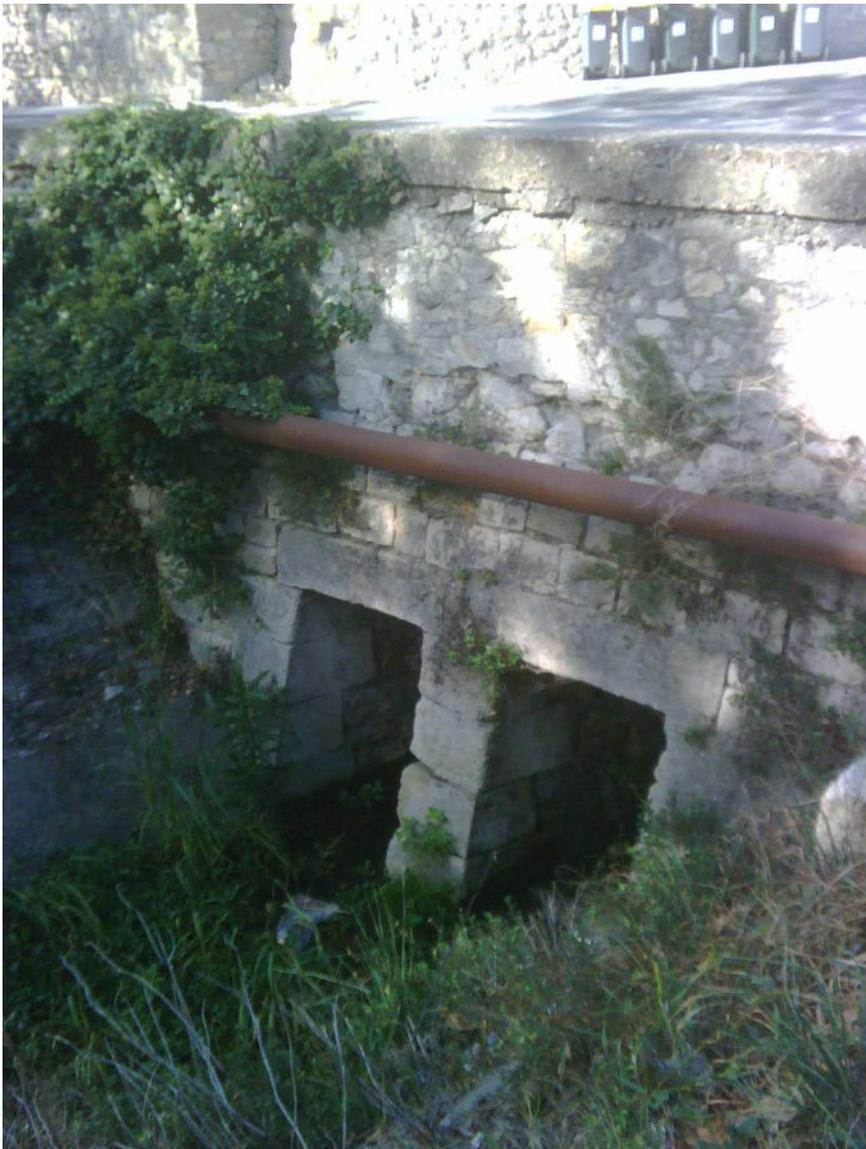
Arrivée d' un émissaire pluvial sous voirie se déversant dans la roubine de la Chartreuse.
