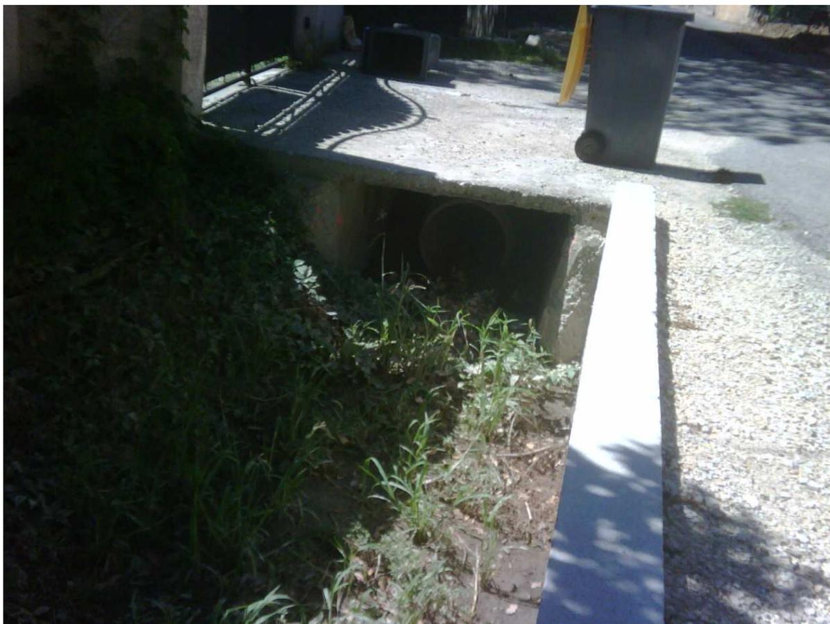
Ouvrage de franchissement du chemin de la Seigneurette. Ouvrage colmaté avec DN 600 à l' intérieur limitant la capacité d' évacuation.
