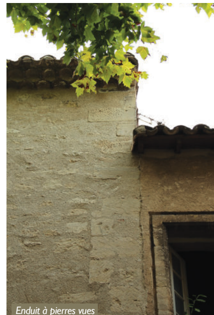
Enduit à pierres vues
