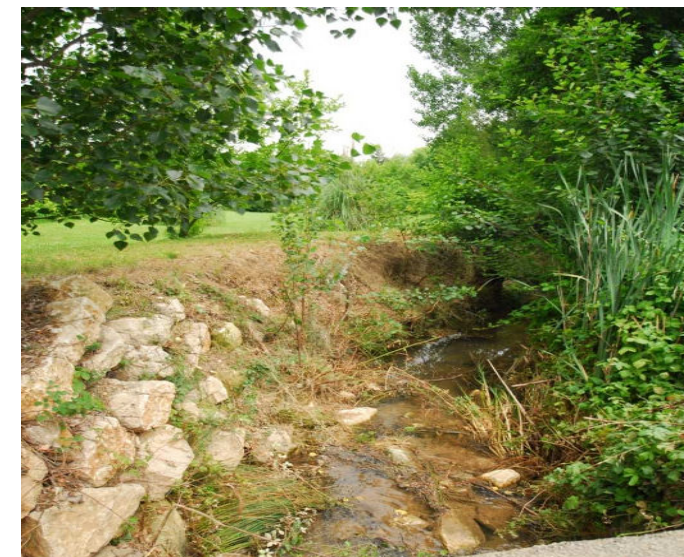
L'Arnavé au lieu dit Mas Cousit, enrochée en amont d'un ouvrage de faible dimension
