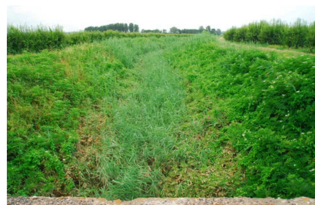
Dans la zone d'expansion des crues du Rhône, l'Arnavé et le Rieuprimen sont recalibrés sous forme de fossés fortement colonisés par la végétation hydrophile
