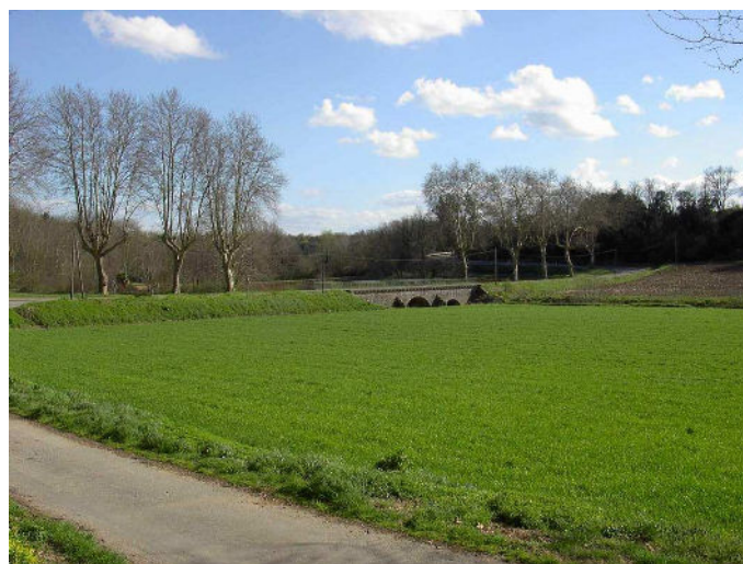
Photo 5 : Remblai barrant la plaine alluviale
