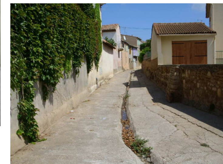
Cadereau en provenance de la Combe Ouest, dans Saint-Gilles, en amont du camping.
