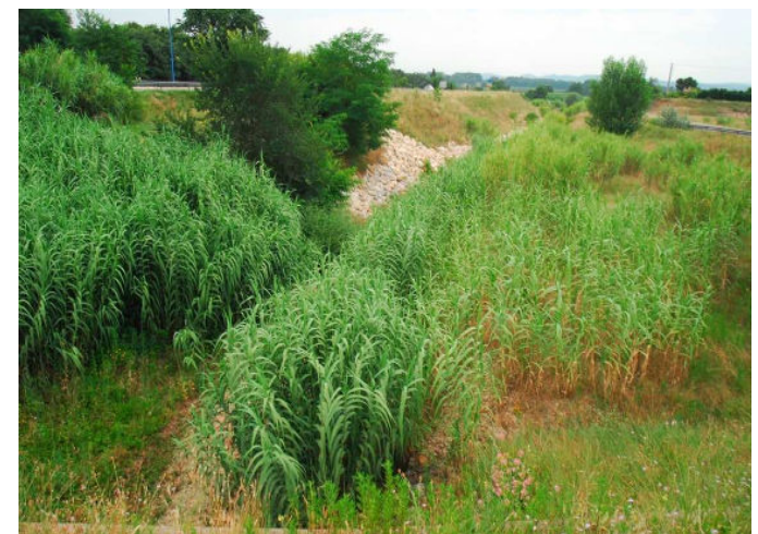
Le chenal construit pour dévier le Rieuprimen, au sud du contournement de Pont Saint-Espirit
