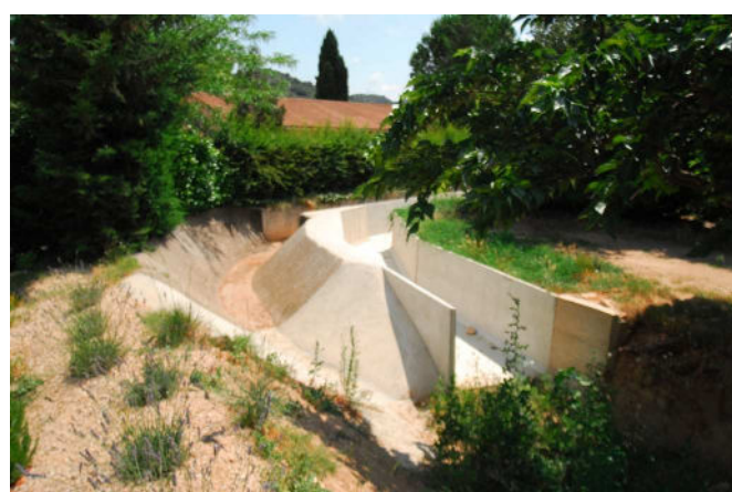
Le double canal bétonné guidant à angle droit le Nizon à l'entrée de Lirac afin de protéger, en cas de précipitation modérées, le quartier résidentiel situé en aval
