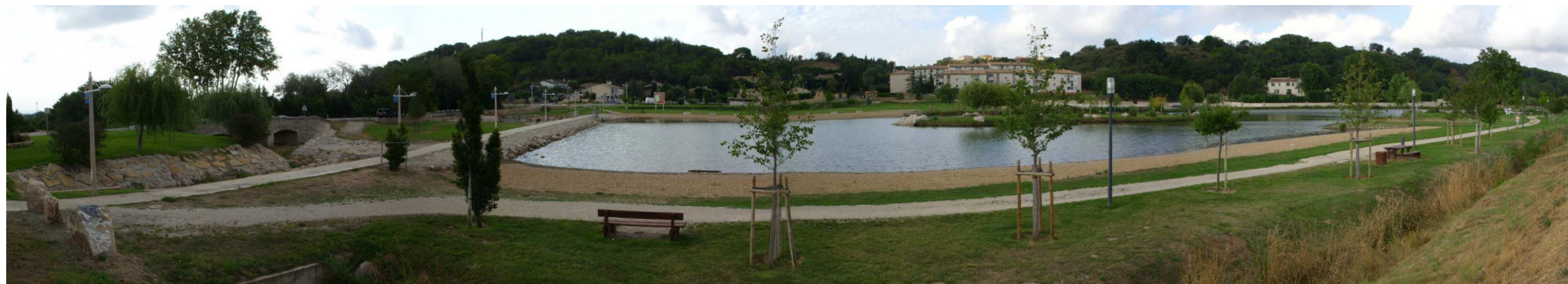
Les aménagements des anciennes carrières situées sur le cours du Rieu, en amont de Bellegarde, peuvent en tant que pièges à sédiments, stocker la part grossière du transport solide provenant des pentes des Costières lors des crues. Les eaux claires sortant de cette zone ont cependant un potentiel érosif supérieur, du fait de cette décharge en matière solide, ce qui pourrait accentuer l'impact de l'inondation sur les secteurs situés directement en aval.
